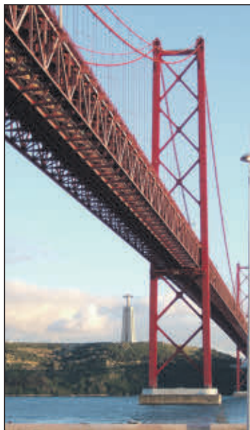
Puente 25 de Abril, en Lisboa. EE
